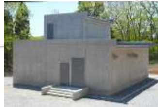
日ノ浜浄水場
