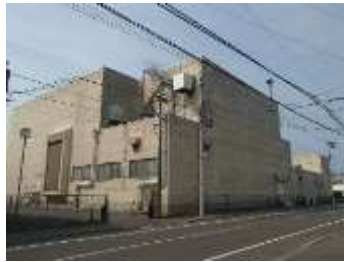
大手ポンプ場 (雨水)
