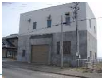
志海苔ポンプ場 (汚水)
