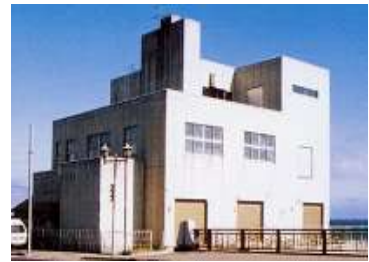
宇賀浦中継ポンプ場 (汚水)
