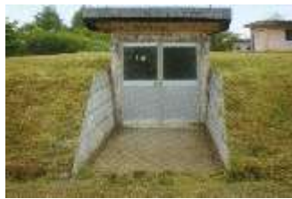
尾札部浄水場
