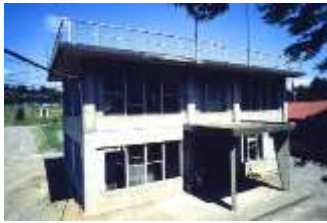
赤川低区浄水場
