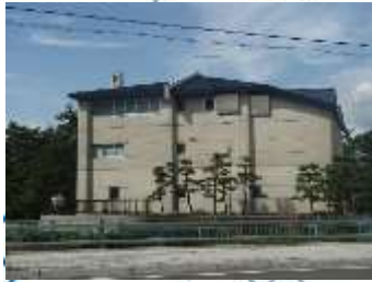
湯川ポンプ場 (汚水)
