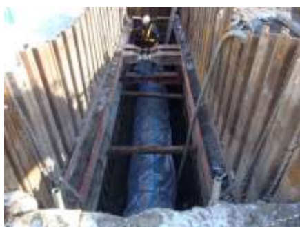
配水管布設工事
