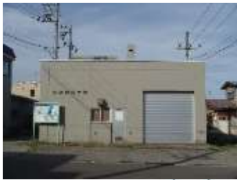
住吉ポンプ場 (汚水・雨水)
