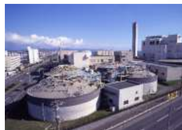
南部下水処理場 汚泥処理施設
