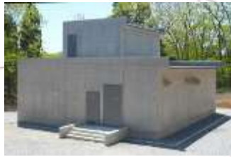
日ノ浜浄水場
