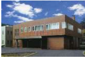
赤川高区浄水場
