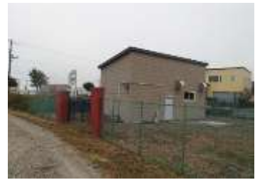
港ポンプ場 (雨水)
