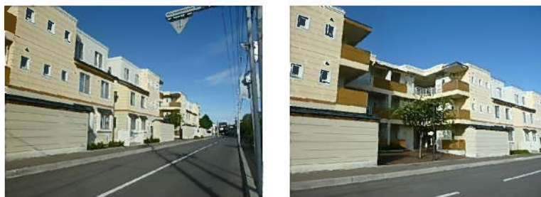
建物の一部を後退させ、植栽を工夫することでボリューム感を軽減した事例
