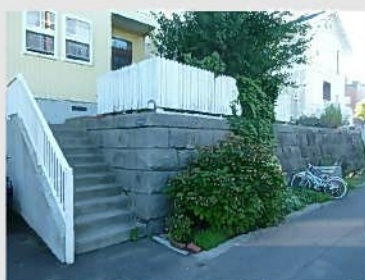
新たに石積みを設置した事例
