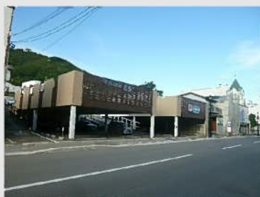
ルーバーで目隠ししている事例
