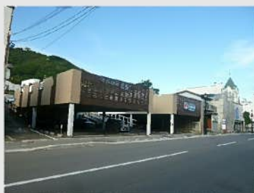
ルーバーで目隠ししている事例
