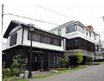
外壁に歴史文化景観に調和した素材を使用した事例
