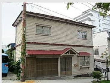
車庫の引き戸を建物の外観の色と調和させた事例
