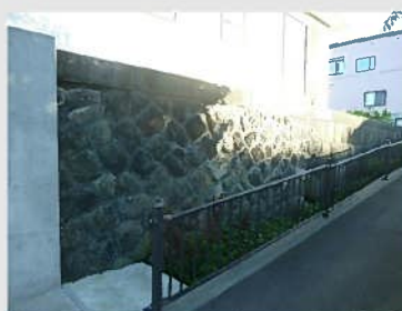
新たに石積みを設置した事例
