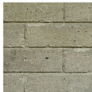
石張り仕上げ
