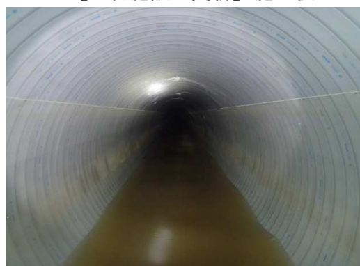
【老朽施設の更新】 施工後
