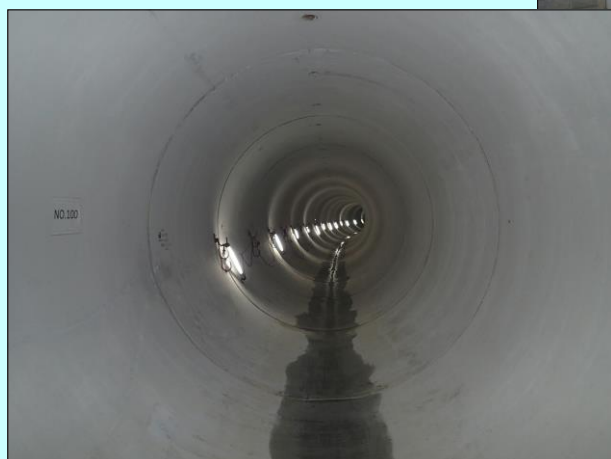
貯留管内部 φ 3,000mm
