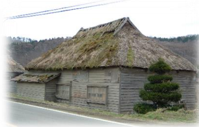
茅葺き屋根建築物（庵原町）
