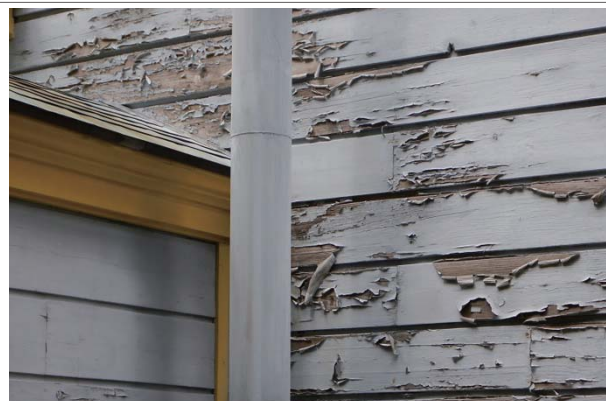
下見板の補修（本館東側）
