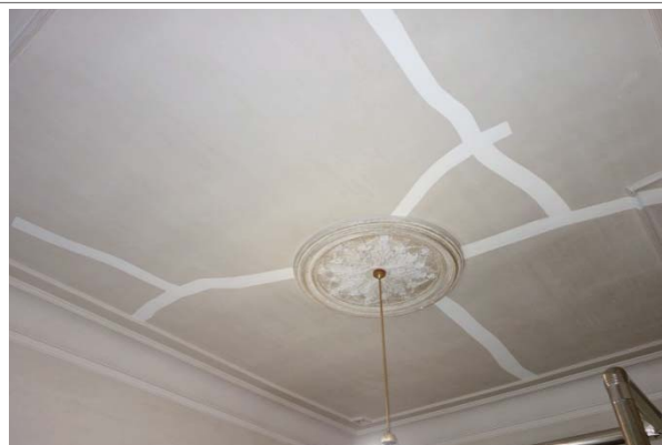
漆喰の補修（本館事務室）
