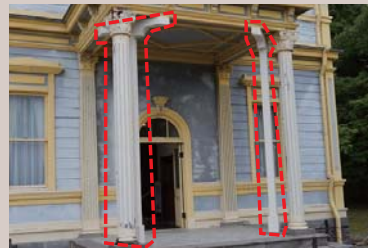
補強柱(本館 西側車寄せ)
