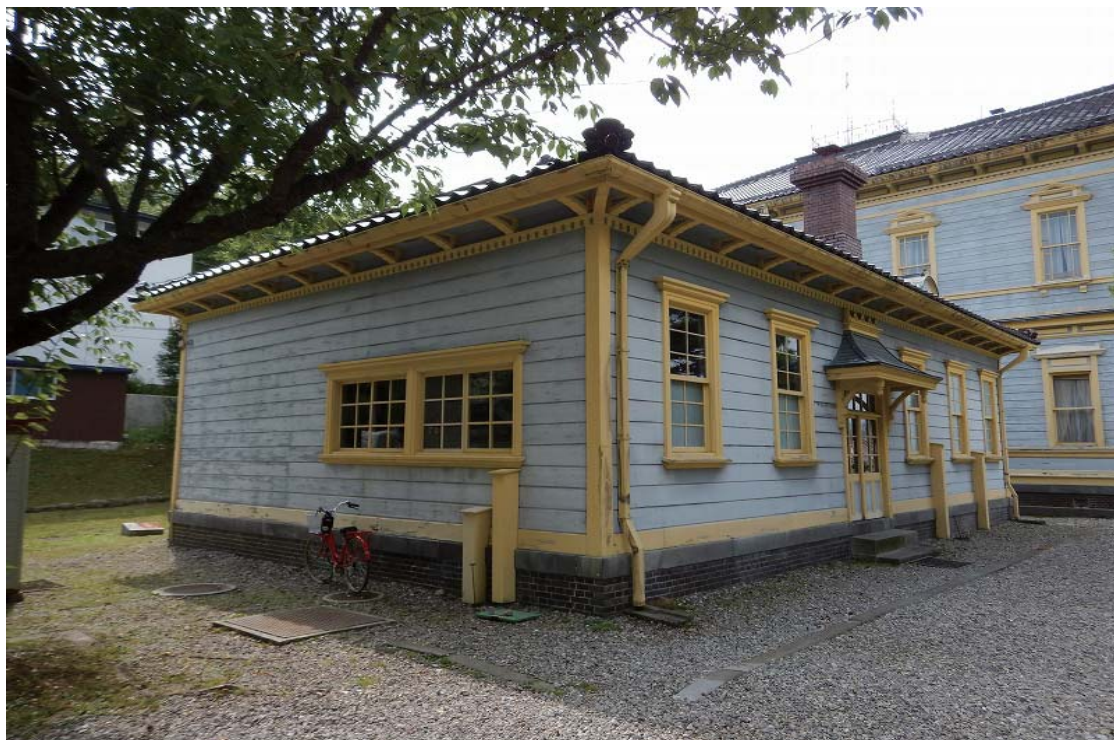
旧函館区公会堂附属棟 外観
