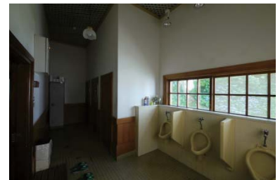
写真 5-18. 共用便所（現状）
