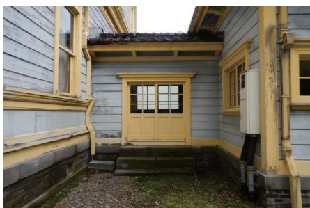
写真 5-12. 附属棟渡廊下 (右図⑤)
