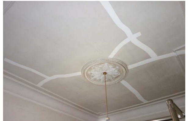
漆喰の補修（本館事務室）
