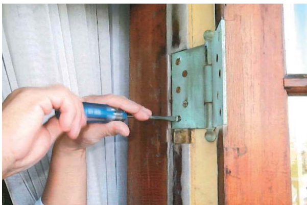
建具金具の締め付け調整（本館甲板）
