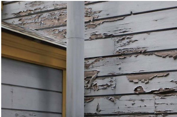
下見板の補修（本館東側）
