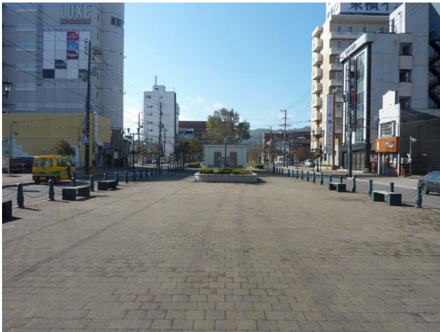
□電線電柱の現況（Cブロック）
