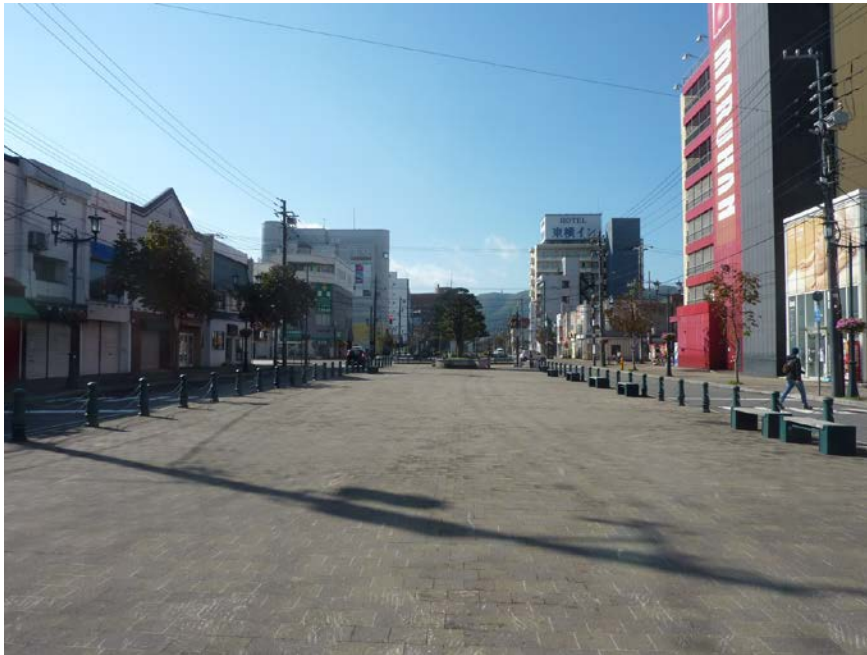
□電線電柱の現況（Bブロック）
