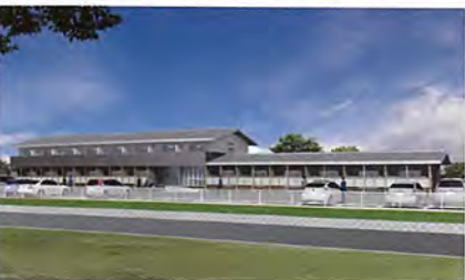
県立農業担い手育成センター 長期研修用宿泊施設 (高知県四万十町)
