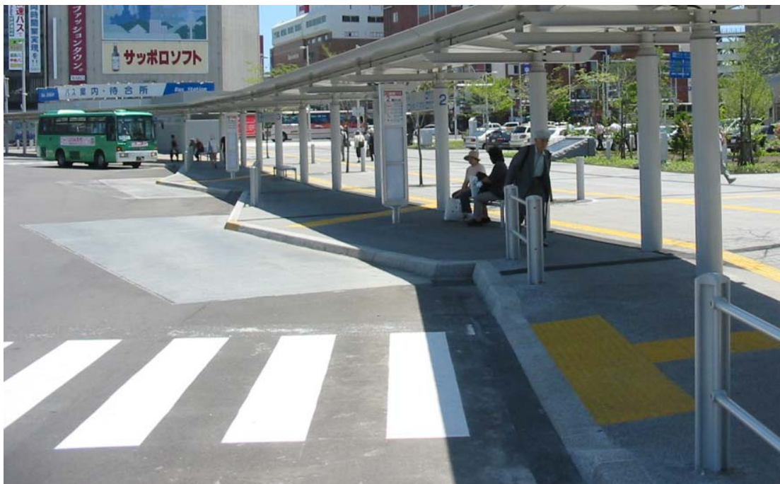
写真：三角形切り込み型停留所のバスターミナル事例（函館駅）
