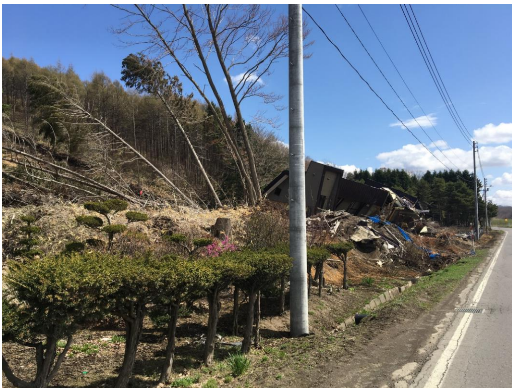
倒壊した建物が道路脇に横たわっていました。
