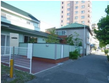
連続した町並みとなるよう 板塀により壁面位置を揃えた事例
