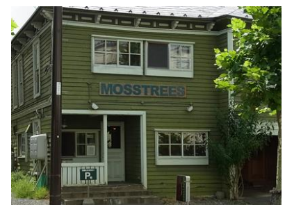
建物と調和する色彩とした広告物の事例
