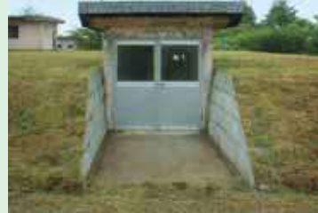
尾札部緩速る過池
