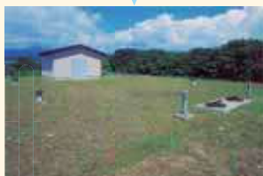
旭岡高区配水池
