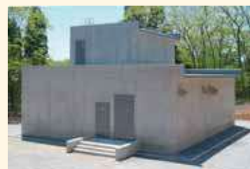
日ノ浜浄水場
