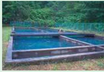
白尻沈でん池
