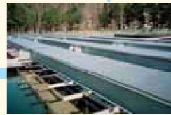
高区薬品沈でん池
