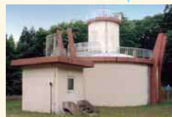
日ノ浜配水池
