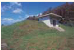
赤川高区第2配水池
