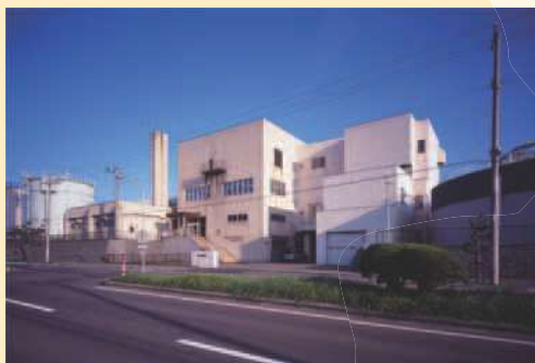
南部下水終末処理場 (汚泥処理施設)
