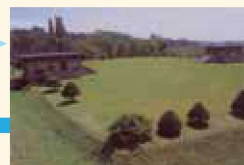
赤川低区配水池
