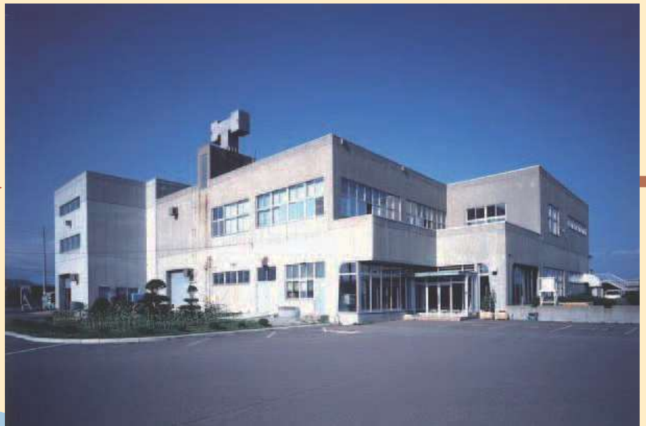
南部下水終末処理場 (污水处理施設)
