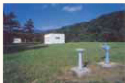
赤川高区第1配水池
