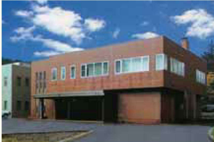
赤川高区浄水場
