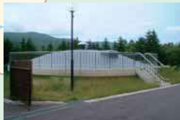
楯法華配水池
