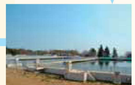
低区緩速ろ過池
