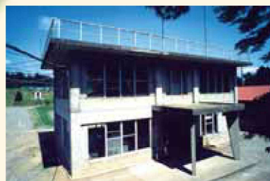
赤川低区浄水場
