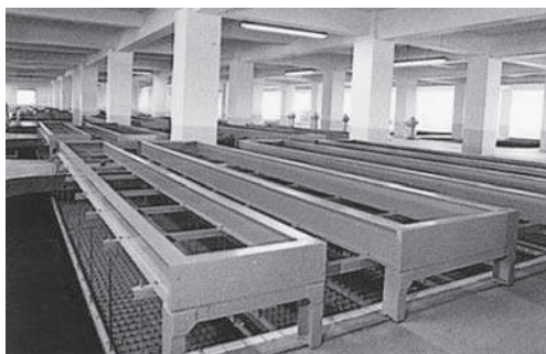
薬品沈でん池
