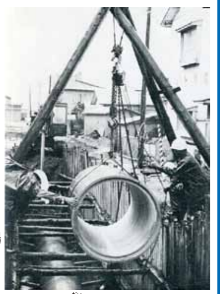
昭和40年代の下水道工事の様子
