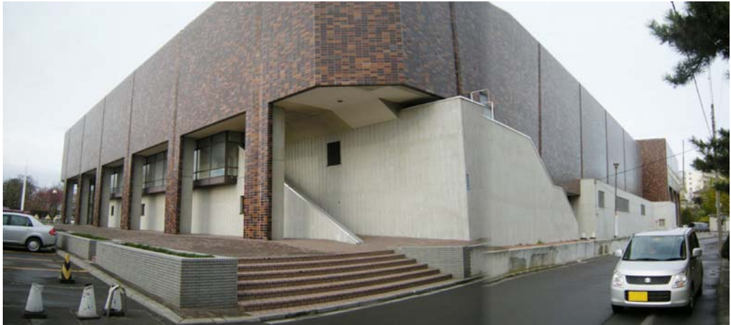
⑥計画敷地東側アプローチより体育館を望む
