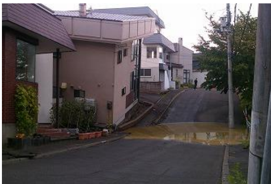
(a) 地盤の沈下と住宅の傾斜
