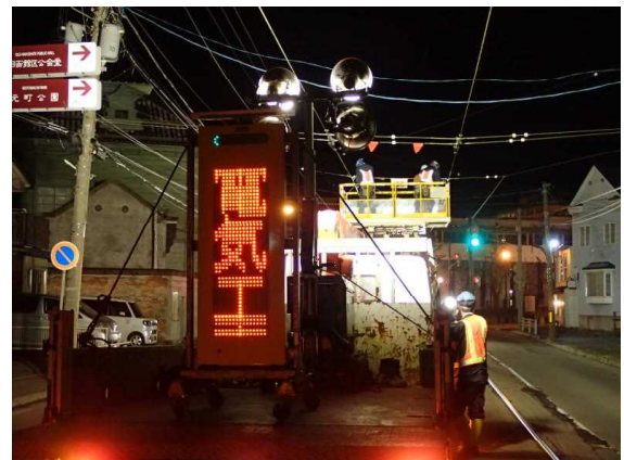
【span線張り替え工事】
