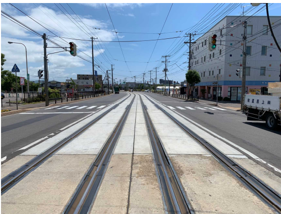
【深堀町～駒場車庫前間】
