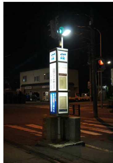
【LED照明 行灯上部】
