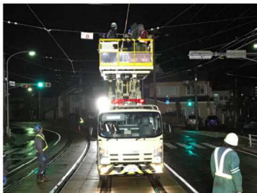
【トロリー線張替工事現場】
