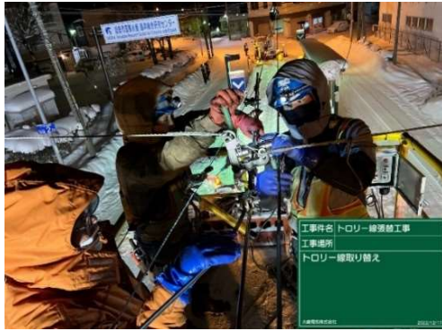
【トロリー線の張り替え】
