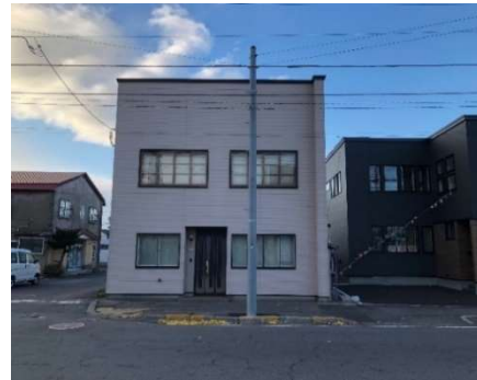
【支持柱の建替え（建替え後）】
