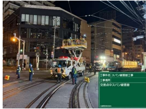
【スパン線の張り替え】
