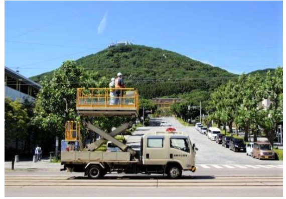
【架線整備の様子】
