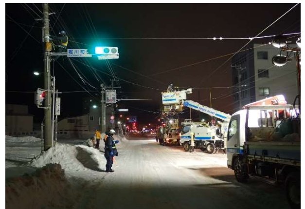
【span線張替工事】
