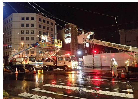
【span線張替工事】
