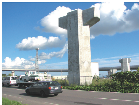
新外環状線の整備が進む函館インターチェンジ
