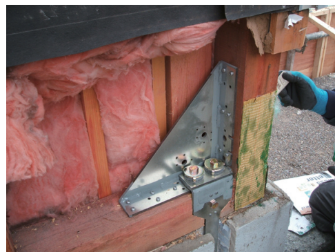
木造家屋の耐震改修
