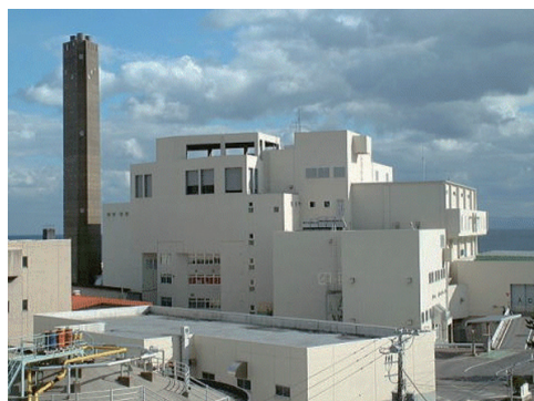
ごみ焼却工場（日乃出地区）
