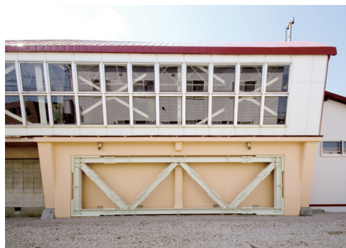
体育館の耐震改修（五稜中学校）
