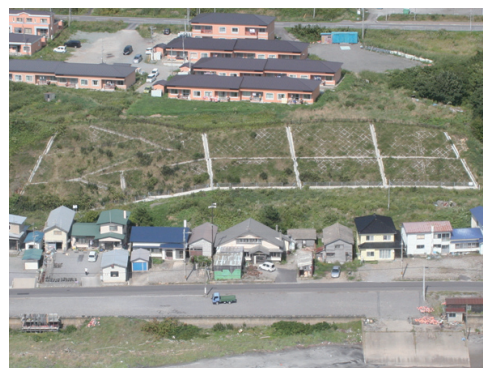
急傾斜地崩壊防止施設（戸井小安地区）
