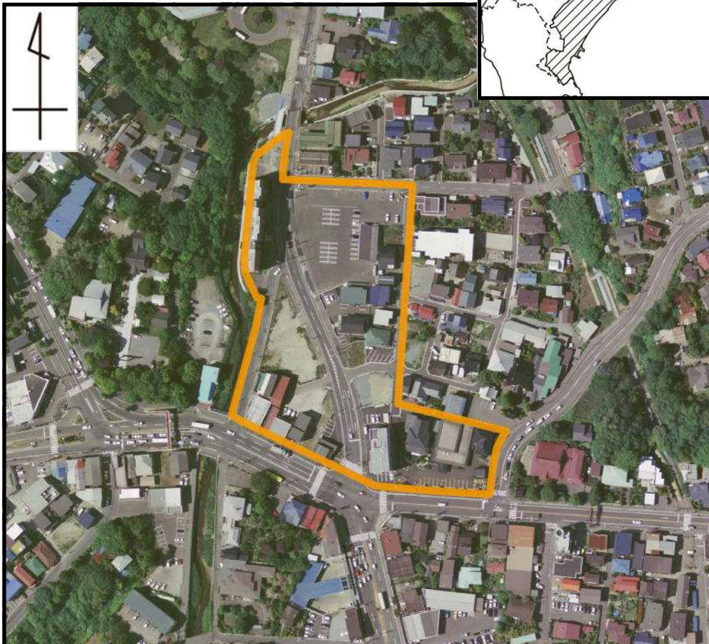
湯川橋地区 ～施行中～ （平成20年撮影）
