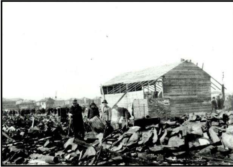
応急住宅の建設
