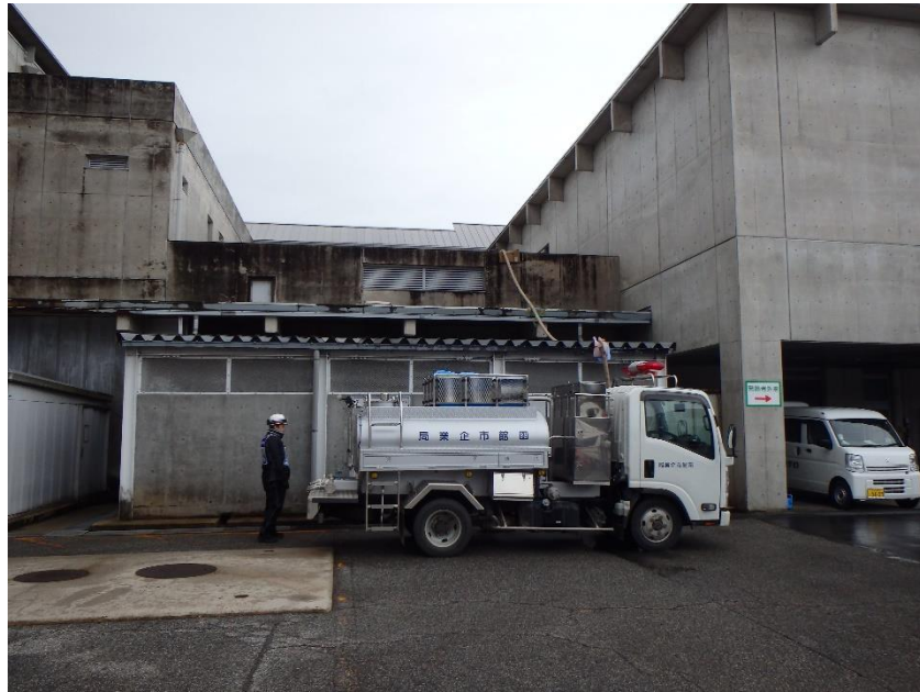
七尾市総合病院 受水槽への給水作業
