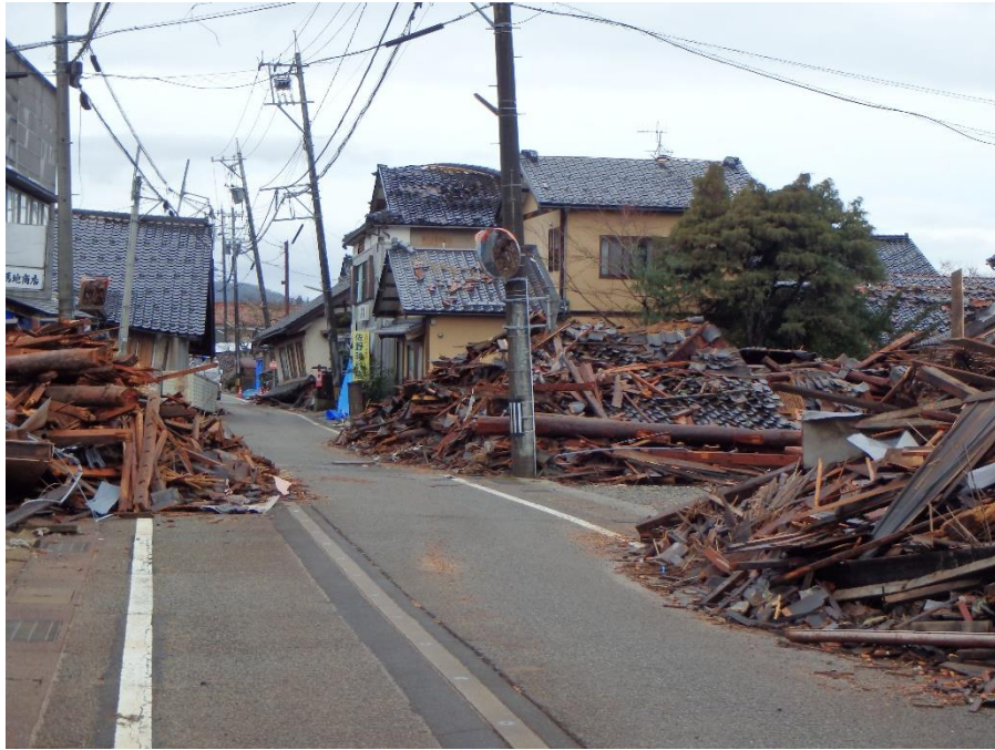
家屋被災状況（珠洲市）
