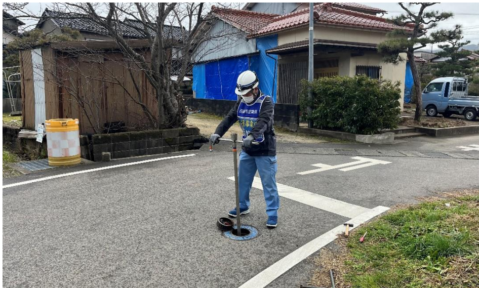
漏水調査のためのバルブ操作（七尾市）
