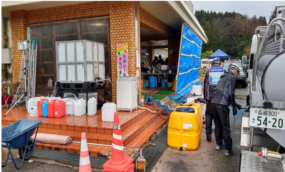
珠州市 避難所仮設タンクへの給水作業
