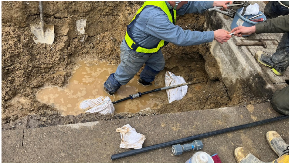
七尾市での管路修繕（函館管工事業協同組合）
