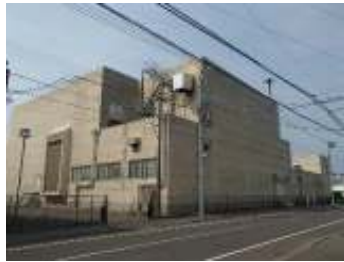
大手ポンプ場 (雨水)
