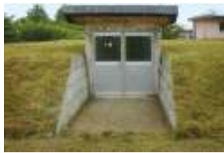
尾札部浄水場
