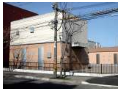
東雲町変電所
