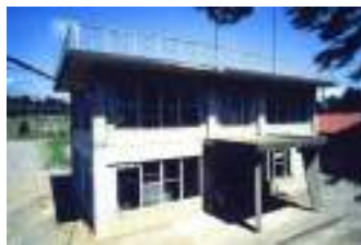
赤川低区浄水場
