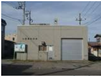
住吉ポンプ場 (汚水・雨水)
