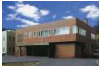
赤川高区浄水場
