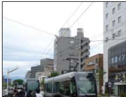
シンプルカタナリー方式吊架例
