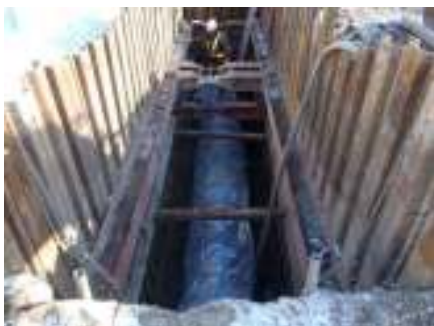
配水管布設工事
