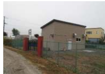
港ポンプ場 (雨水)
