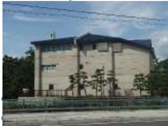
湯川ポンプ場 (汚水)
