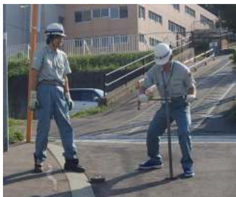
断水作業仕切弁操作訓練
