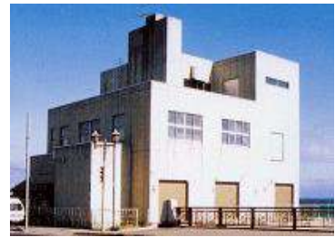
宇賀浦中継ポンプ場 (汚水)
