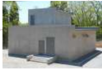
日ノ浜浄水場
