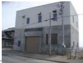
志海苔ポンプ場 (汚水)
